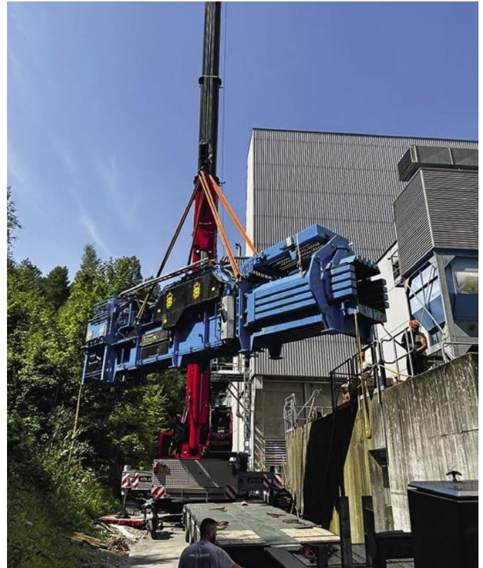
Ausbringen einer BOA-Ballenpresse Typ D130 mit etwa 44 Tonnen bei der KVA Linth in Niederurnen.
