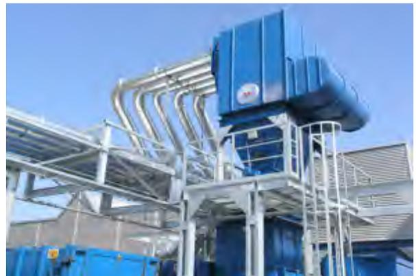
*Absauganlage für Randstreifen- und Stanzabfälle mit Rotationsabscheider und stationärem Presscontainer*
