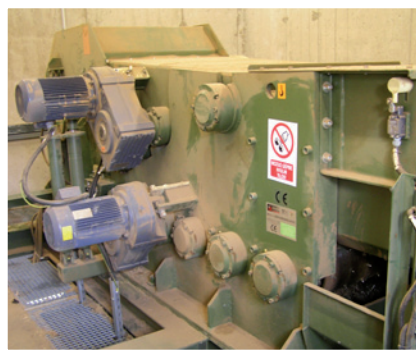
Montage der Förderstrecke – Ansicht Kettenquerförderer auf Schwerlastvibrorinne
