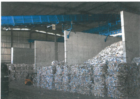
4 Bunkerzellen à 1'500 t Altpapier, Total 6'000 t
