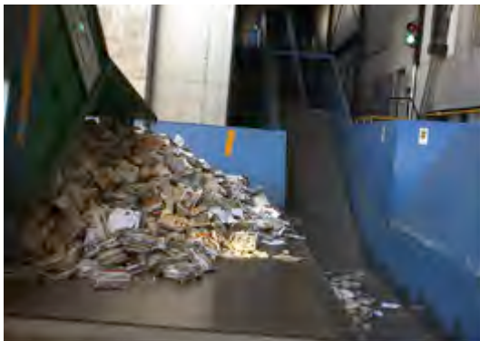
Materialaustrag auf den Pendelplattenförderer
