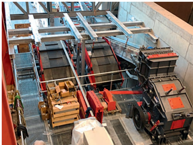
Montage FE-Metallabscheidung / Prallmühle
